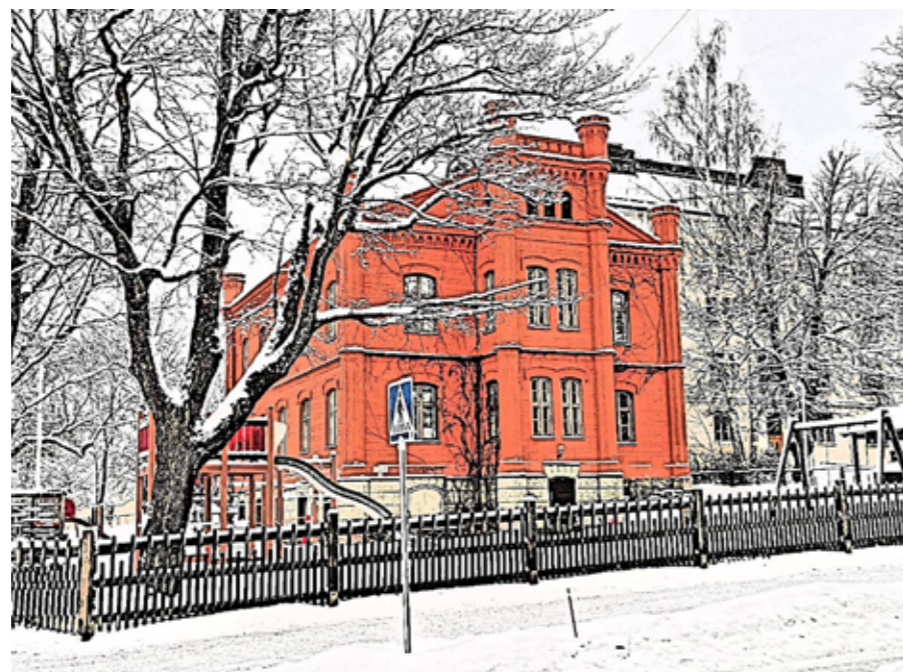
Förra veckans hus: Järnvägsstationen
