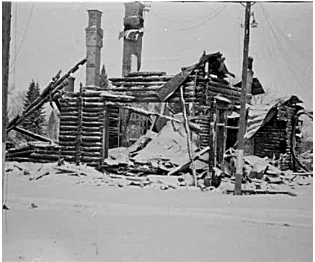
En förstörd byggnad i Neitsytmiemi i Viborg. Viborg 1940.03.13 SA-KUVA
