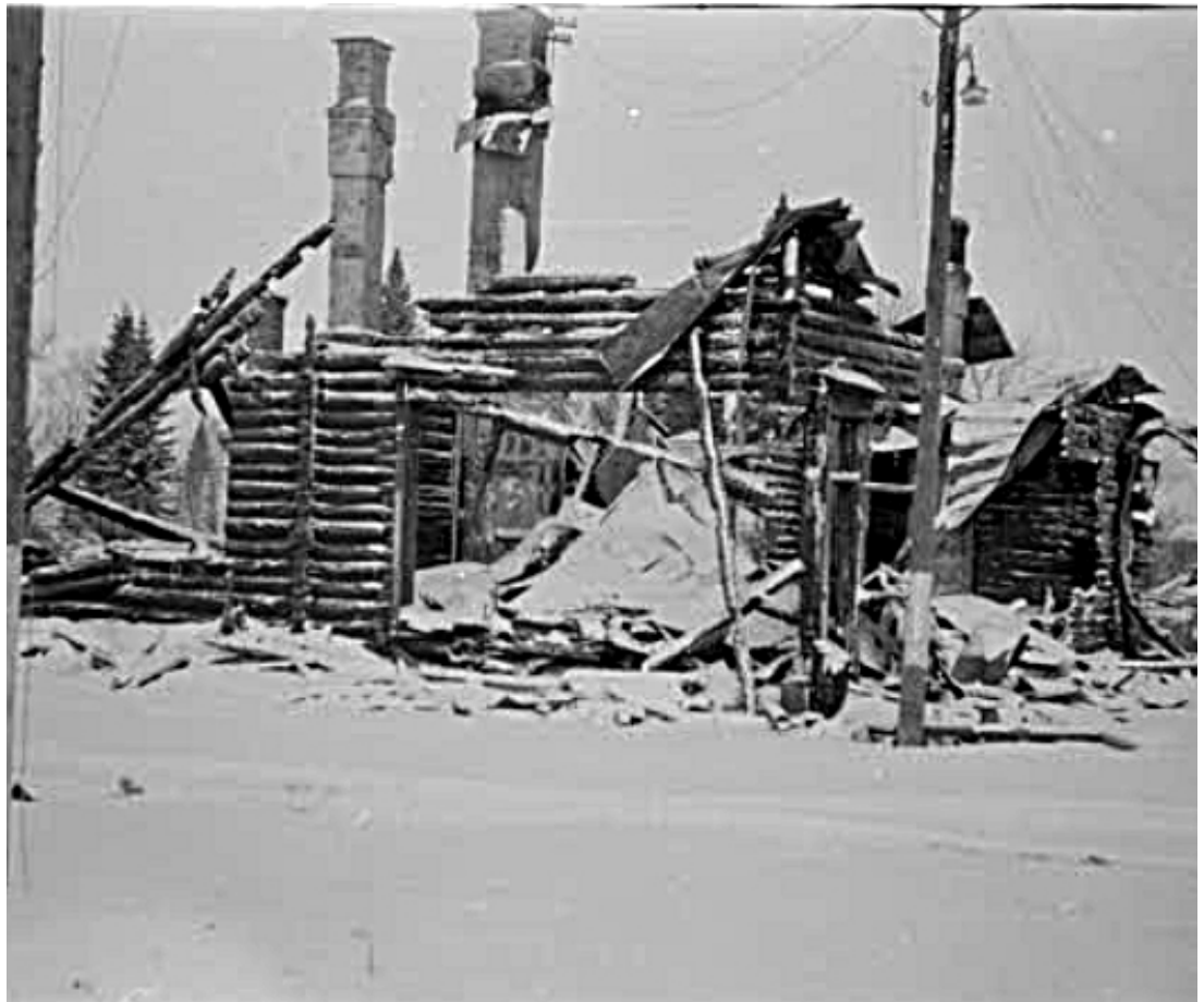
Tuhoutunut rakennus Viipurin Neitsytniemessä. Viipuri 1940.03.13 SA-KUVA
